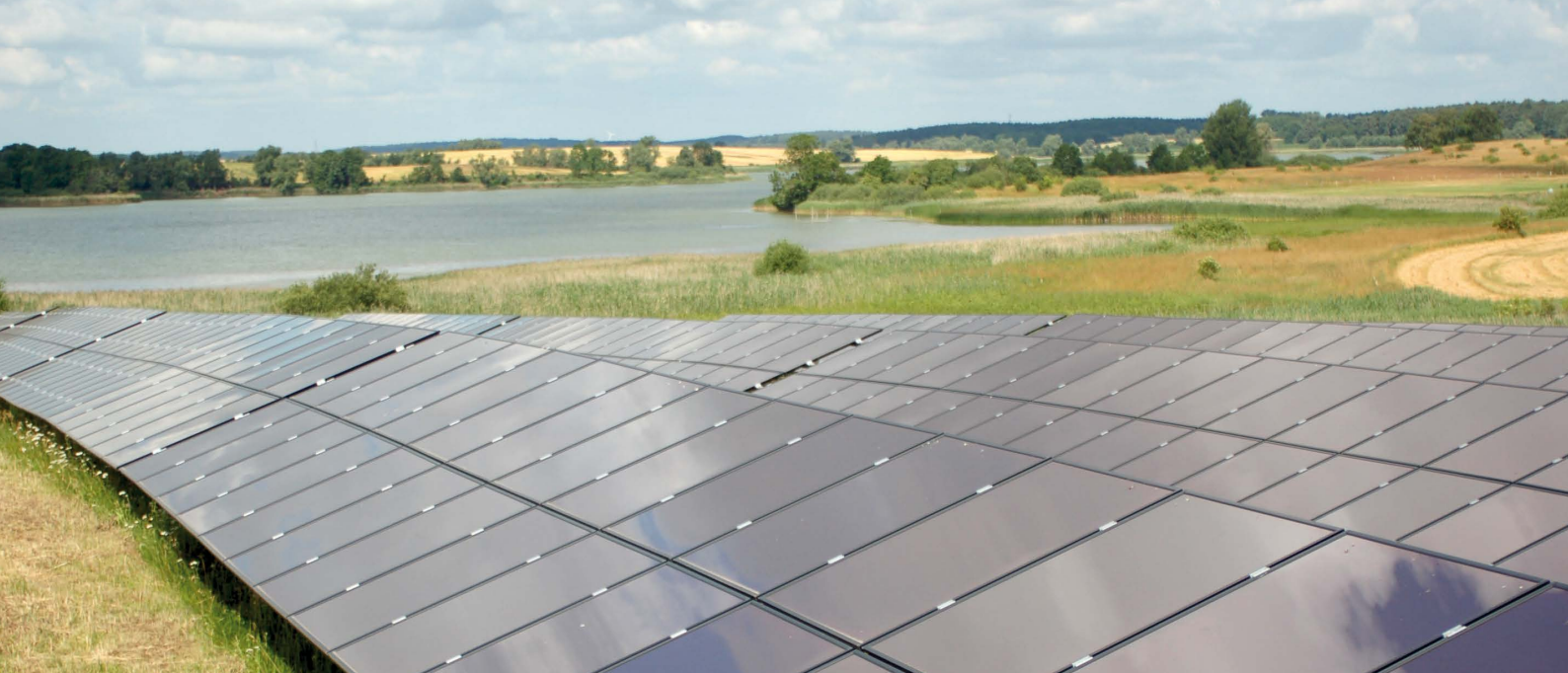
Solarpark Blankenberg – Anlageobjekt Solarenergie Nord
