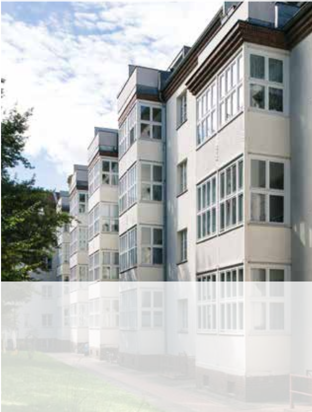
Wohnanlage Pieskower Weg 2-14/ Storkower Straße 13, Bezirk Pankow
