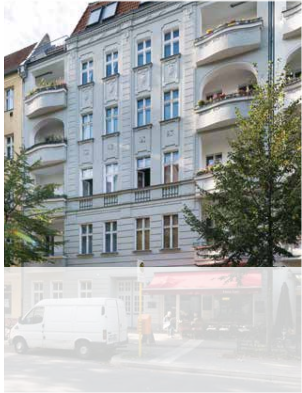
Wohnanlage Karl-Kunger-Straße 18, Bezirk Treptow-Köpenick
