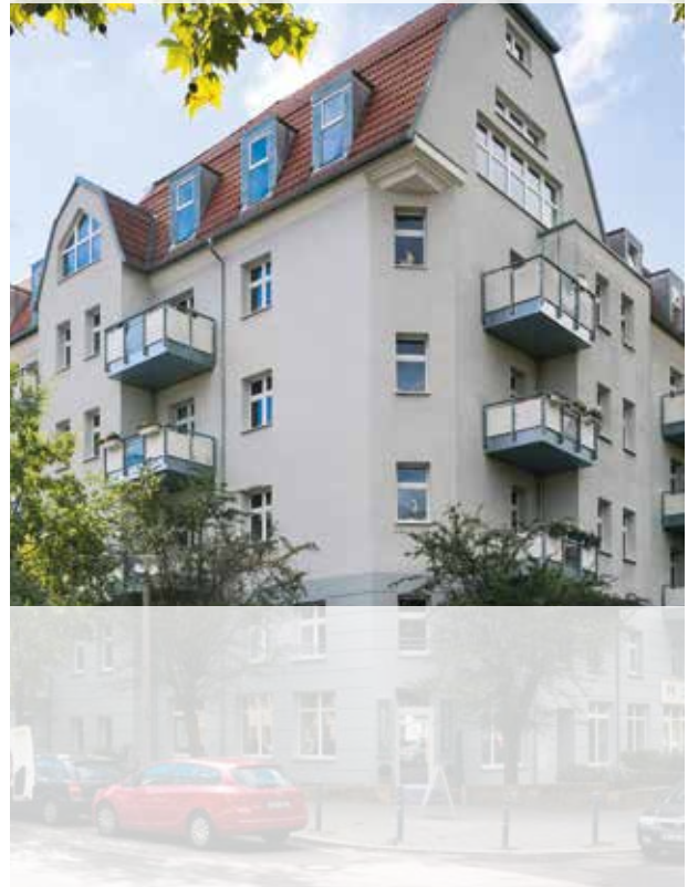
Wohnanlage Kissingenstraße 4, 4a/ Arkonastraße 61, Bezirk Pankow
