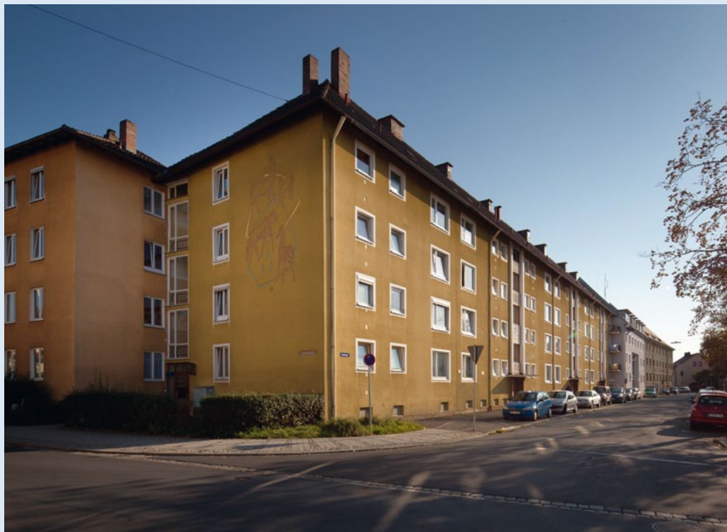
Sanierungsbeispiel Kronach, ZBI Professional 6, Abbildung links: 2011, rechts: nach Sanierung 2013
